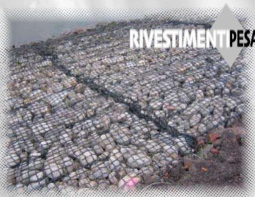
Con velocità fino a 8 m/s vengono proposti rivestimenti più pesanti, tipo KDW, che hanno un peso variabile da 400 a 500 kg/m<sup>2</sup> a seconda del modello. Hanno larghezza fissa di m 2, divisi in comparti da cm 40, e altezza variabile da 4 a 6 metri. Lo spessore è di circa cm 30.
