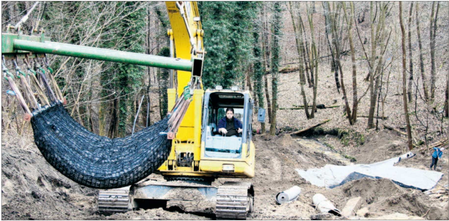
Mit einem Gabelstapler werden die etwa zwei Tonnen schweren Kammerdeckwerke zu dem im Bau befindlichen Tosbecken (Hintergrund) gebracht und dort miteinander vernäht. Der Gabelstapler fährt rückwärts, um auf Grund der steilen Böschung und der schweren Last kein Übergewicht zu bekommen.
